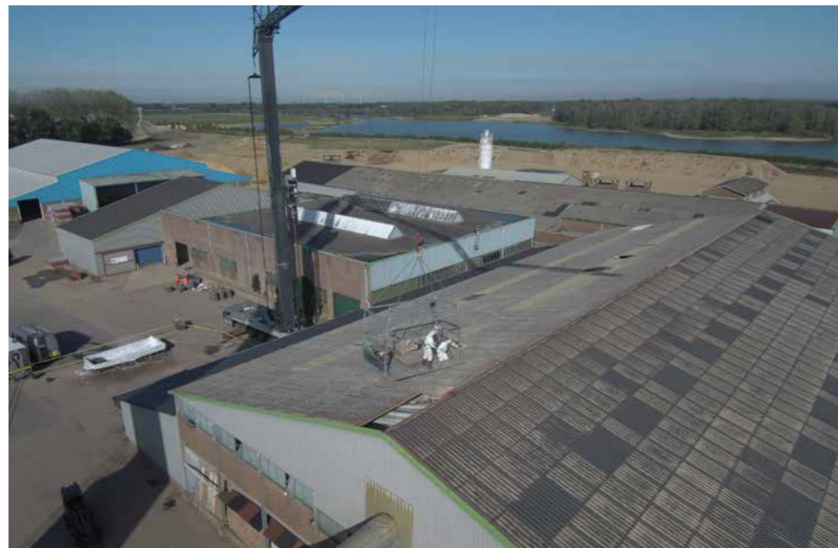
Bommel kreeg een nieuw, asbestvrij dak
